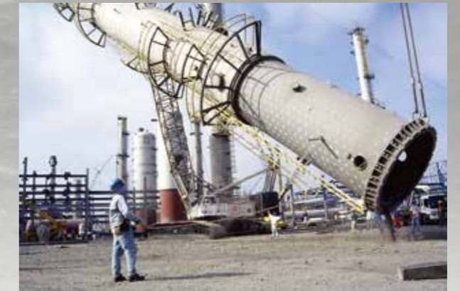
廠房與塔槽安裝
