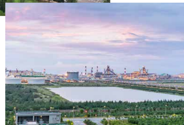
台塑河靜鋼鐵公司
